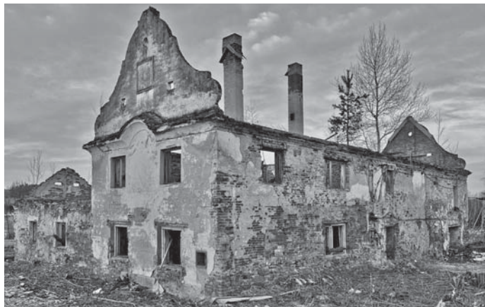
Současný stav obytné budovy dvora.
